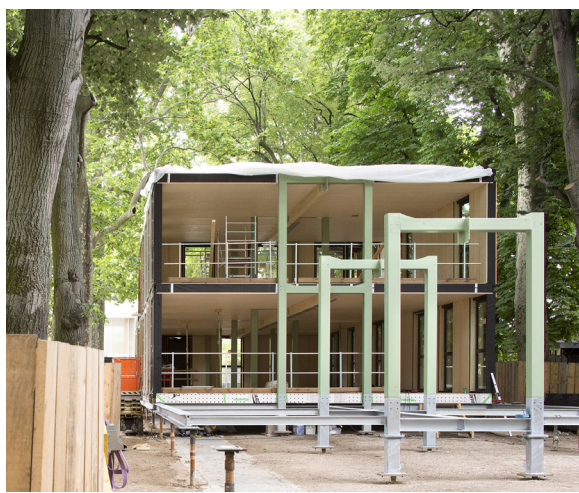
▲ La préfabrication des portiques en acier et des modules en bois permet un montage efficace du bâtiment sur site.
