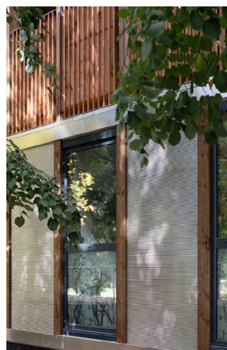
▲ Panneaux vitrés ou opaques et claire-voie bois rythment les façades.
