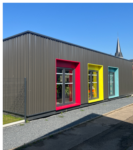
▲ L'isolation et le bardage ont été réalisés sur site
