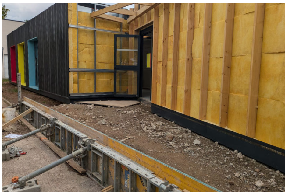
▲ L'isolation et le bardage ont été réalisés sur site
