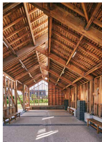
Structure en bois apparente.
