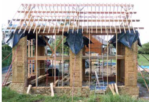
▲ La pose de la charpente sur les piliers en bauge.
