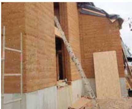
⚠ Le soubassement en béton banché protège la terre crue des remontées d'humidité.
