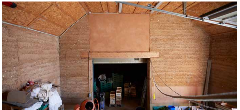
⚠ Avant d'être recouvertes par l'enduit ou le bardage, les strates de la terre compactée du pisé sont visibles.
