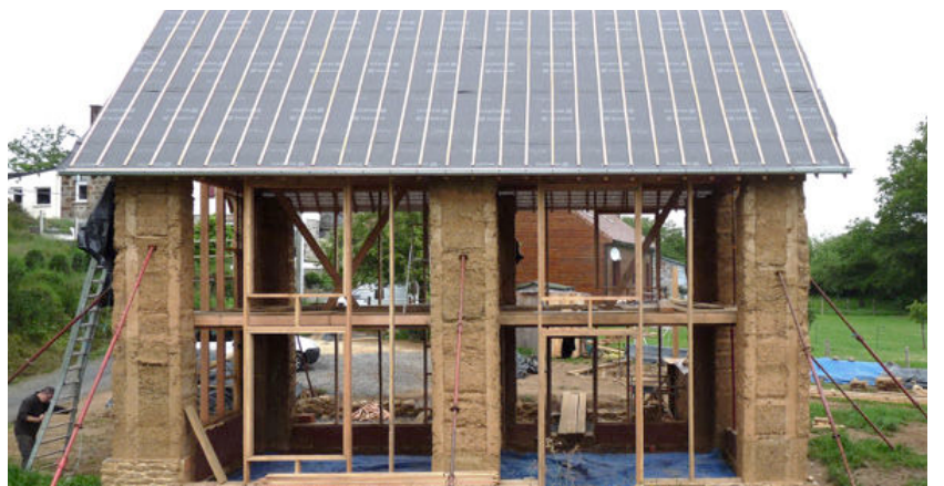
▲ Pose de la toiture sur la charpente bois
