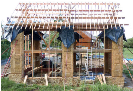
▲ La pose de la charpente sur les piliers en bauge.
