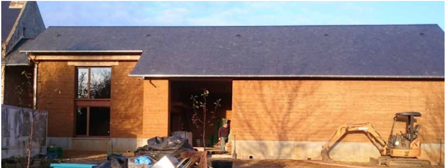
⚠ Avant d'être recouvertes par l'enduit ou le bardage, les strates de la terre compactée du pisé sont visibles.
