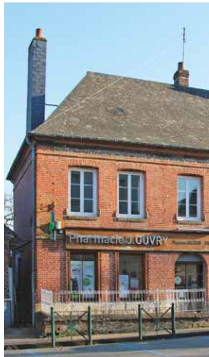
*Les ouvertures du rez-de-chaussée ont conservé l'alignement avec les fenêtres de l'étage. Le trumeau n'a pas été supprimé.*
