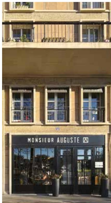
*En bois ou en métal, la devanture en feuillure permet des profilés soignés qui valorisent l'architecture du bâtiment. L'encadrement préfabriqué en béton de la Reconstruction est mis en valeur.*
