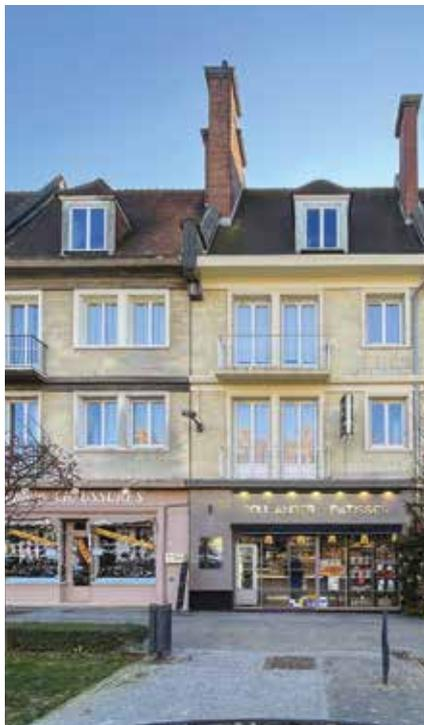
*Chaque commerce respecte le rythme parcellaire. Les descentes de charges sont bien marquées par des panneaux pleins en rez-de-chaussée. Les ouvertures des vitrines sont alignées avec les fenêtres des étages. Cela permet de conserver un gabarit adapté au centre-ville.*
