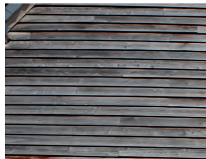
BARDAGE TRADITIONNEL pose horizontale. Recouvrement en Méleze
