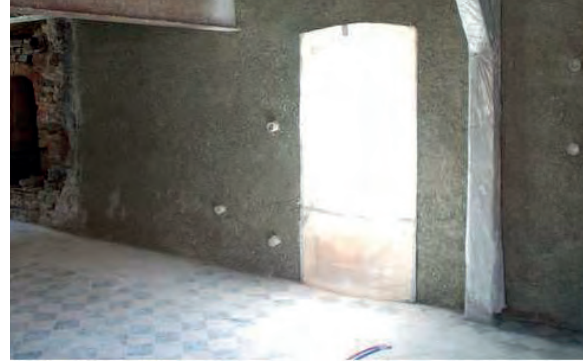
Isolation en mortier chaux chanvre
