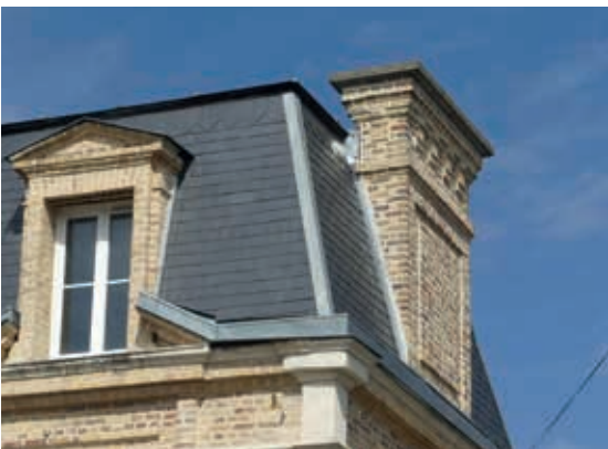
> Souche de cheminée ouvragée
