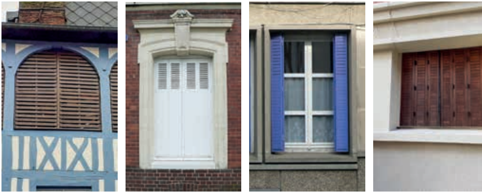
> Panneau fixe à claire-voie > Volet à persienne en bois > Volet à persienne en métal > Volet plein en bois
