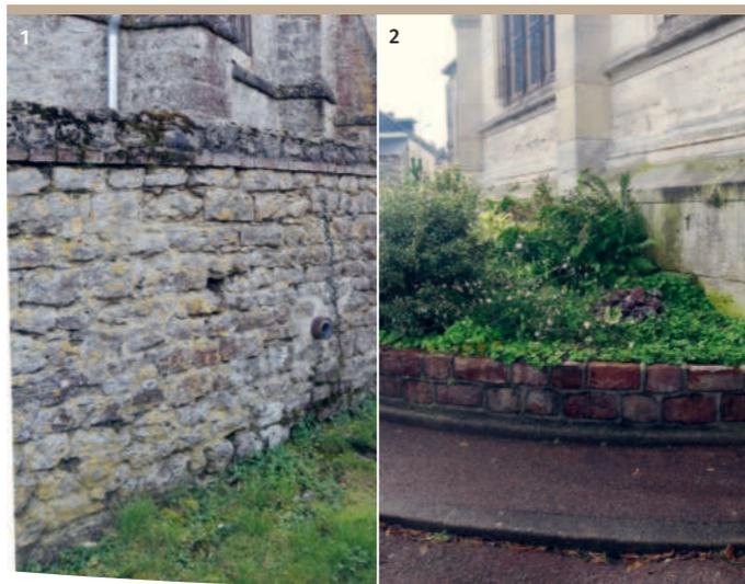
1 Joints du mur de soutènement de l'enclos paroissial creusés
