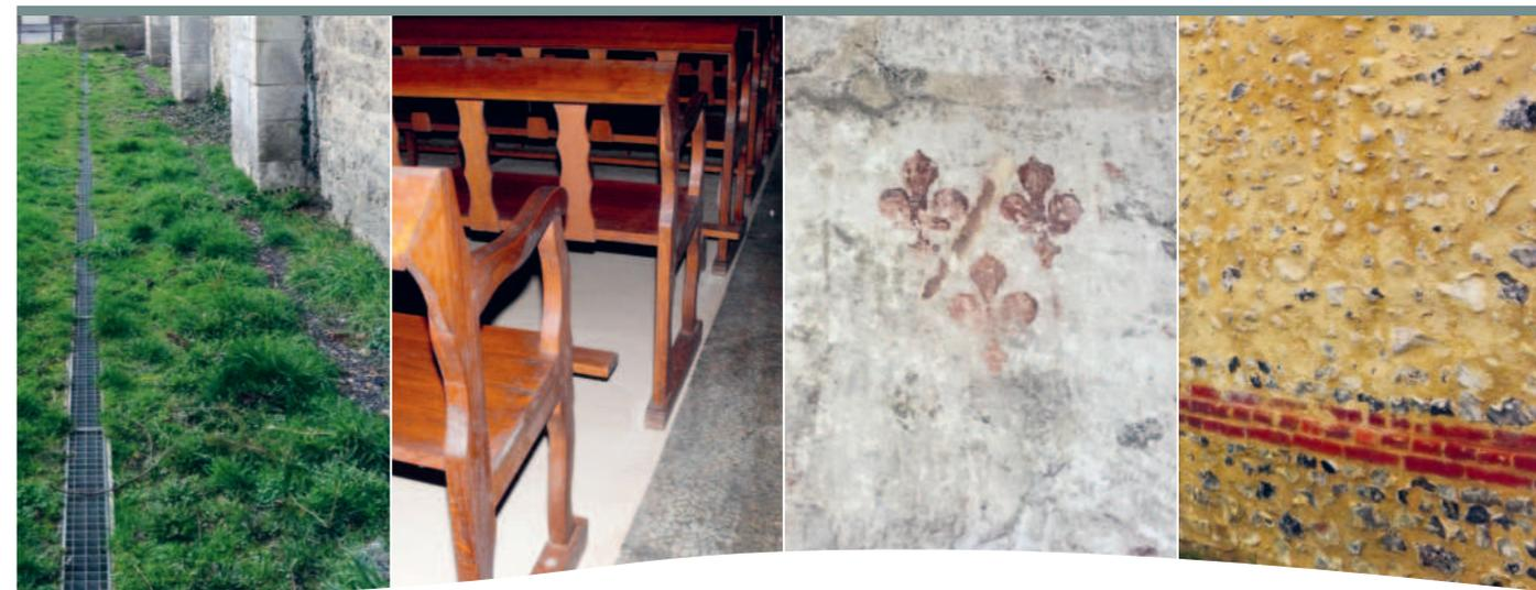
1 L'absence de gouttière doit être palliée par la mise en place d'une rigole/caniveau au niveau du sol.
