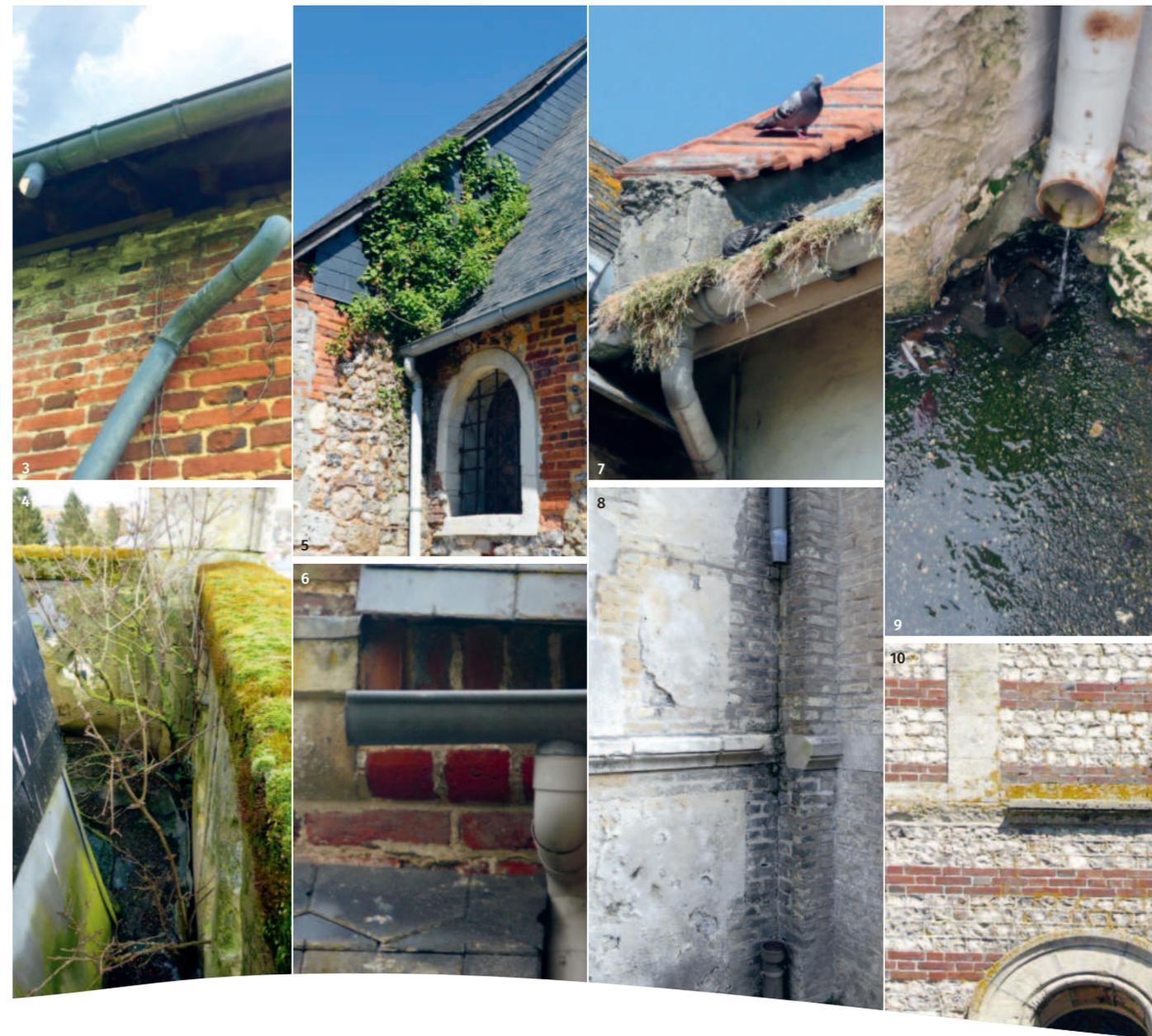
3 Décrochement de la descente d'eaux pluviales
