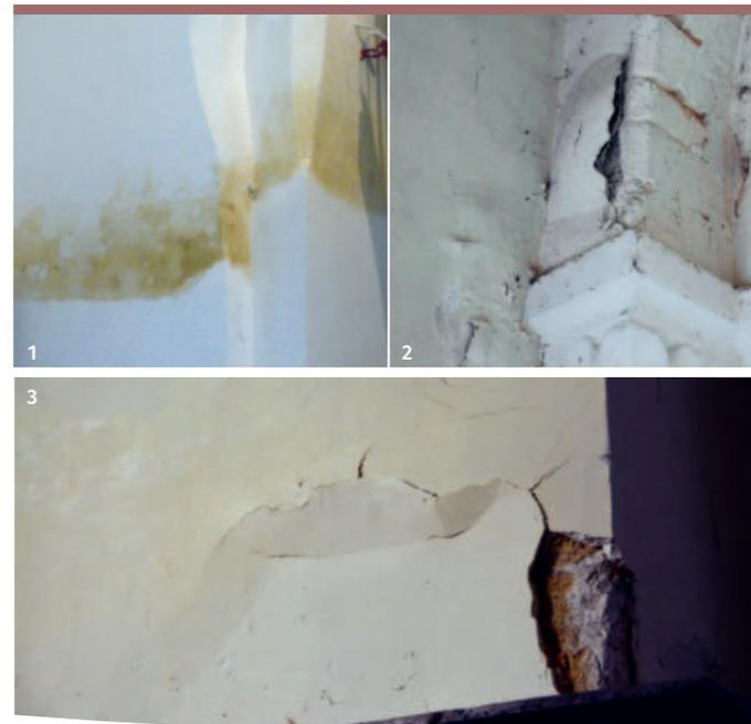
1 Tâches d'humidité apparaissant au-dessus de l'enduit ciment
