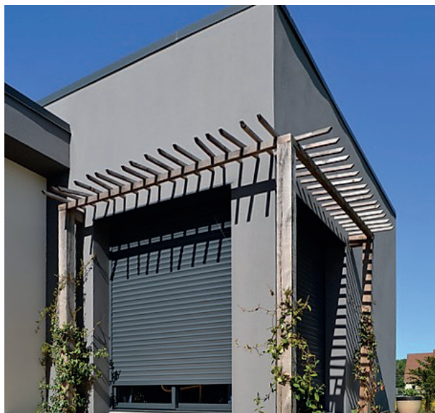
3 Des brises soleils ont été installés pour protéger du soleil d'été.
