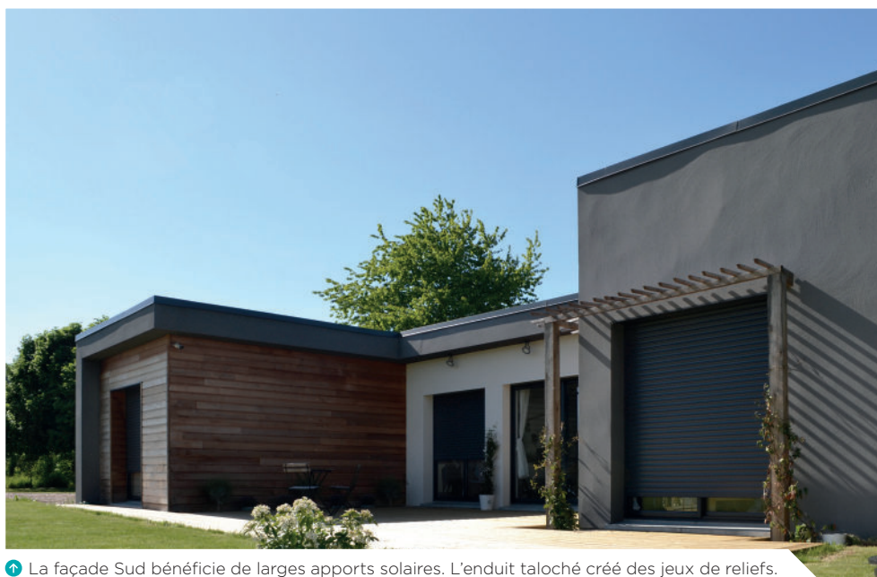
1 La façade Sud bénéficie de larges apports solaires. L'enduit taloché crée des jeux de reliefs.
