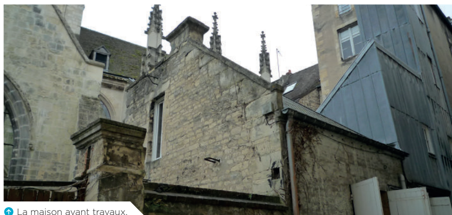
➔ La maison avant travaux.
