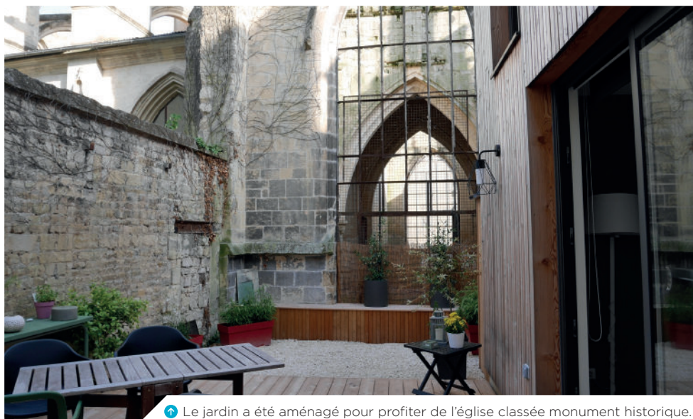
↑ Le jardin a été aménagé pour profiter de l'église classée monument historique.
