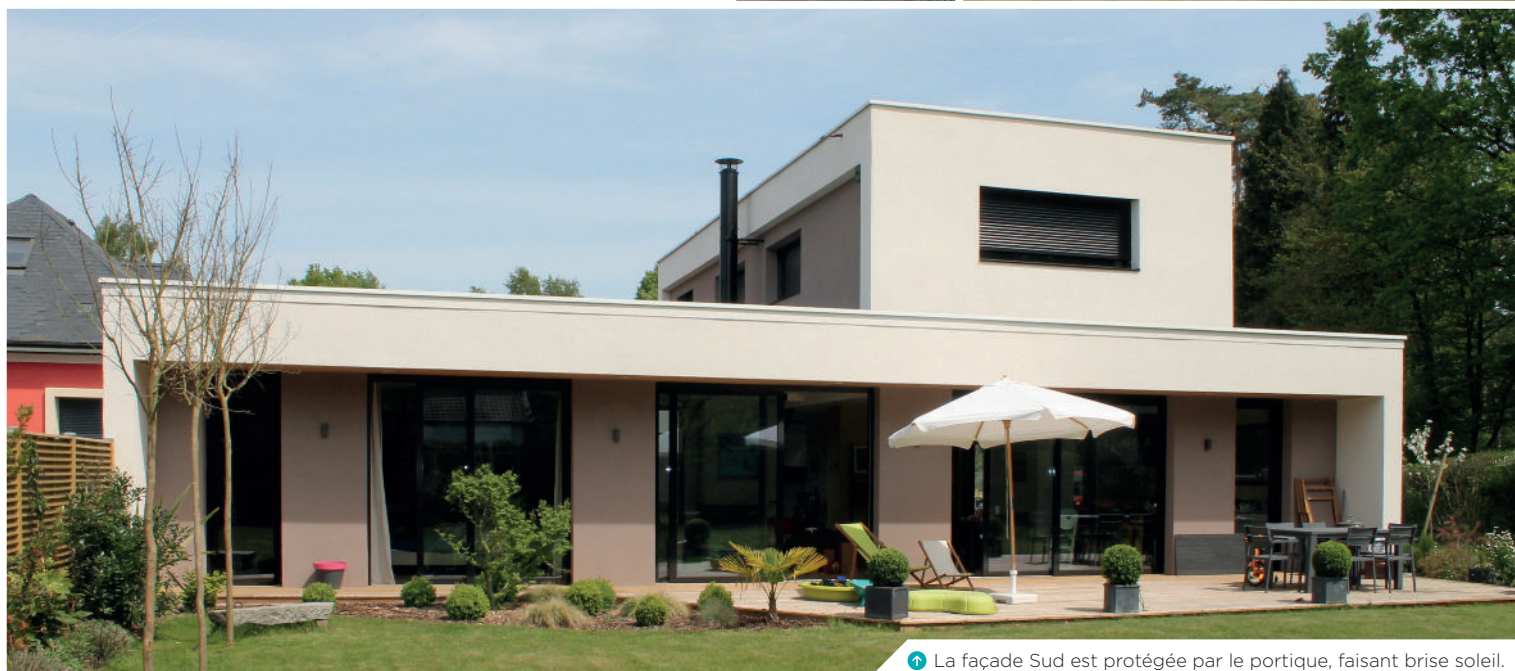
⬆ La façade Sud est protégée par le portique, faisant brise soleil.
