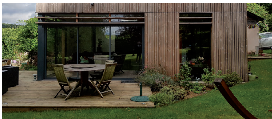
↑ Le niveau de plancher de l'extension a été calé au plus près du terrain naturel.
