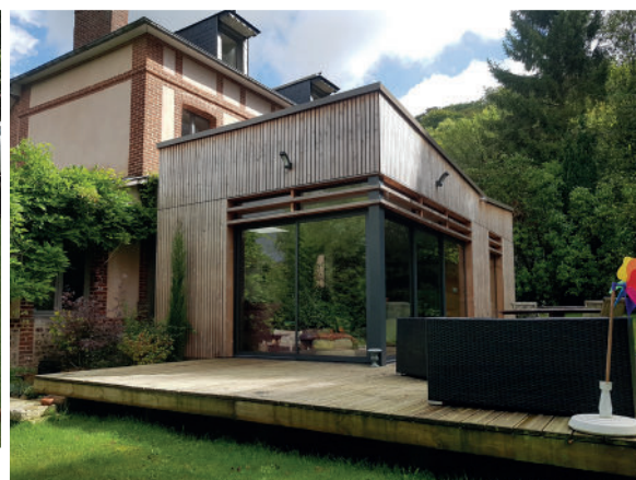
↑ Le niveau de plancher de l'extension a été calé au plus près du terrain naturel.
