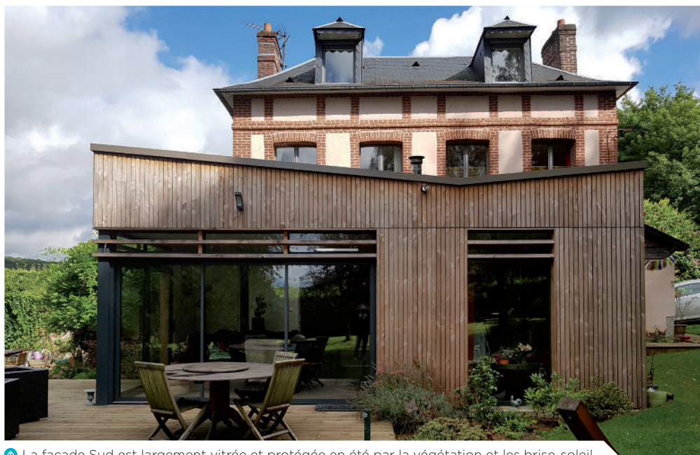
⬆ La façade Sud est largement vitrée et protégée en été par la végétation et les brise-soleil.
