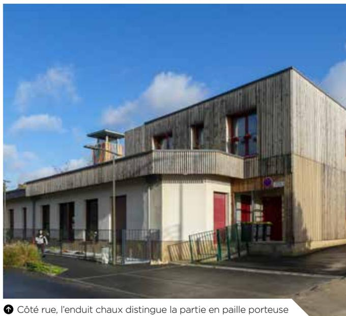
3 Côté rue, l'enduit chaux distingue la partie en paille porteuse
