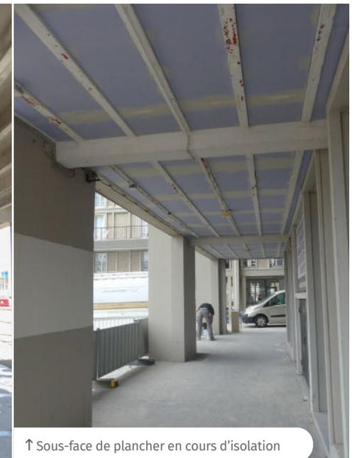
↑ Sous-face de plancher en cours d'isolation
