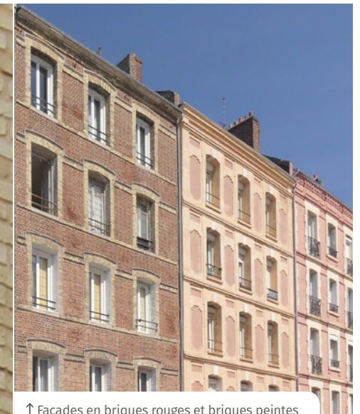
↑ Façades en briques rouges et briques peintes
