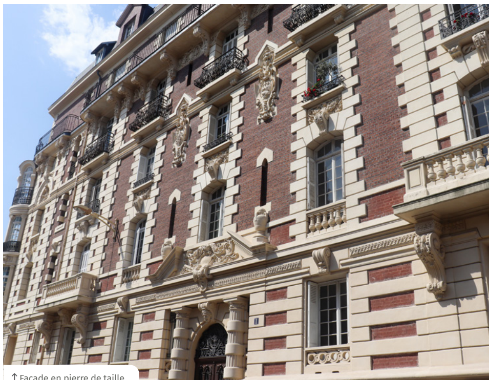
↑ Façade en pierre de taille
