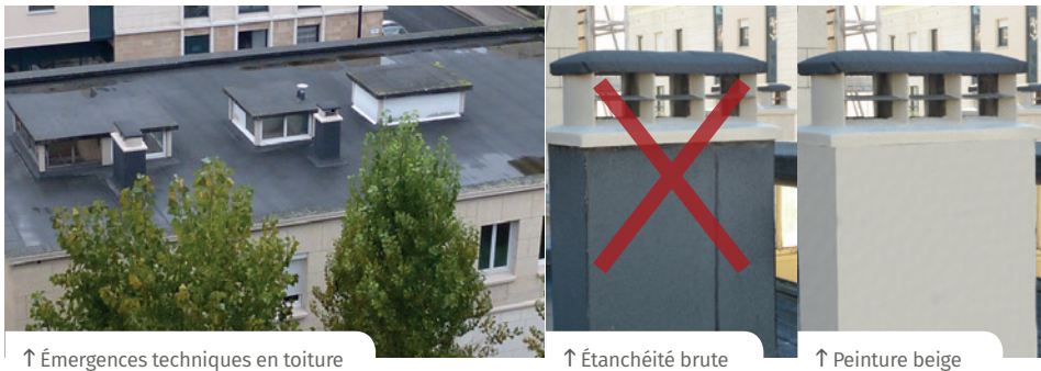
↑ Émergences techniques en toiture
