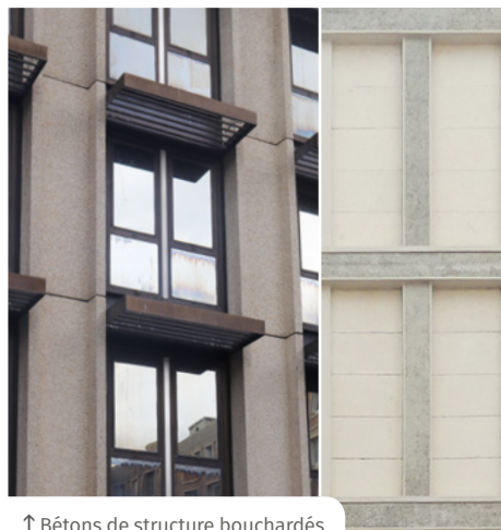
↑ Bétons de structure bouchardés
