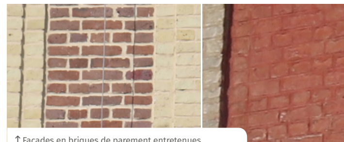
↑ Façades en briques de parement entretenues
