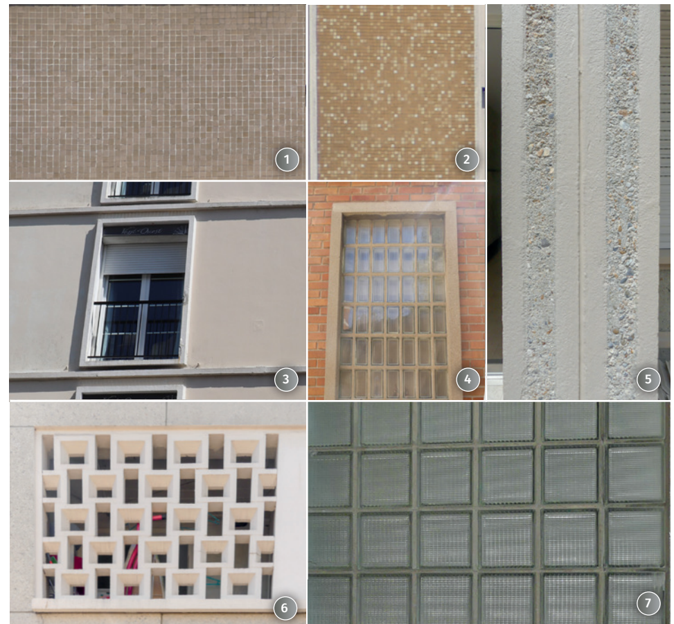
1-2. Revêtements de façades en pâte de verre
