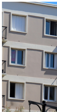
↑ Bétons de structure lisses
