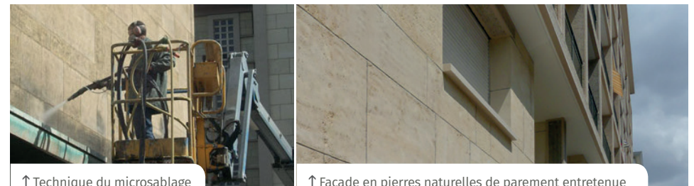
↑ Technique du micro-sablage
