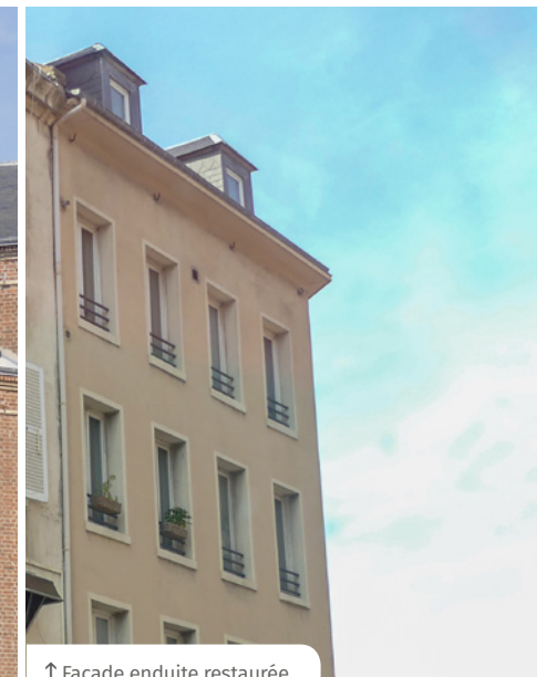
↑ Façade enduite restaurée
