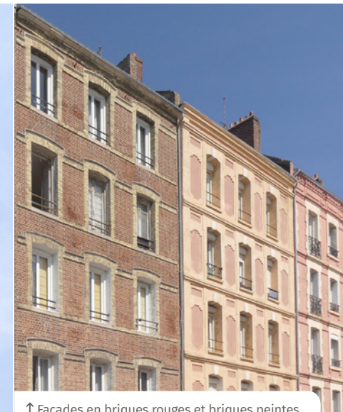
↑ Façades en briques rouges et briques peintes
