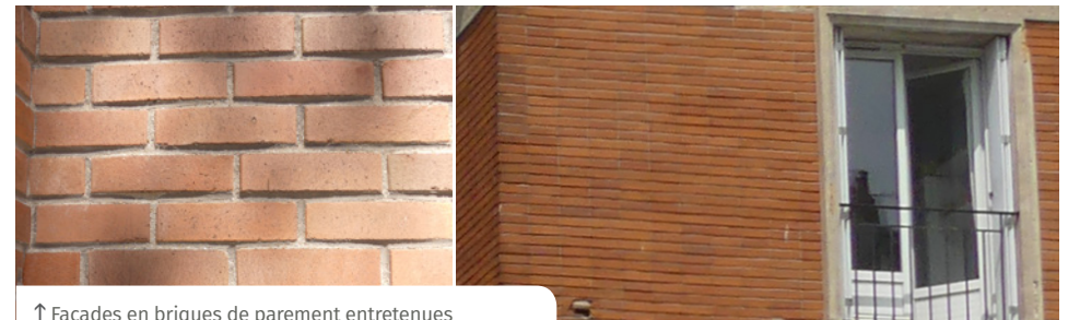
↑ Façades en briques de parement entretenues
