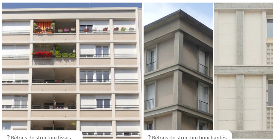
↑ Bétons de structure lisses
