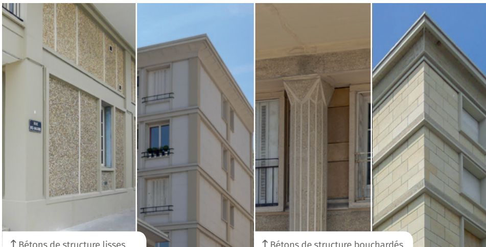
↑ Bétons de structure lisses
