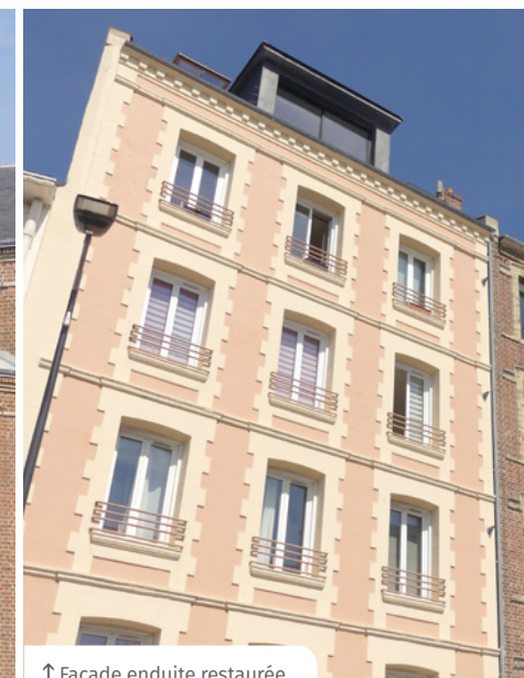
↑ Façade enduite restaurée
