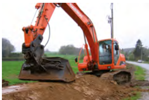
↑ Nivellement des flancs et du sommet.
