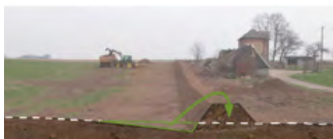
1 Exemple de décapage en pied de talus.
