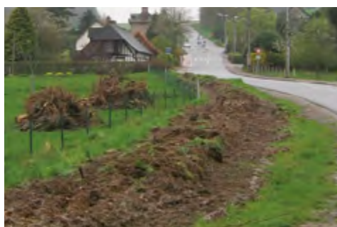
↑ Préparation de l'emprise du talus.
