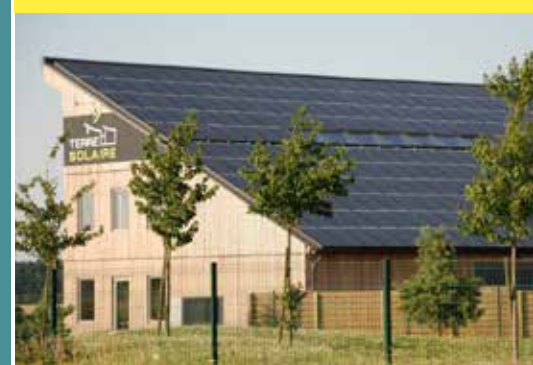
v Terre solaire (27) Bâtiment avec toiture photovoltaïque
