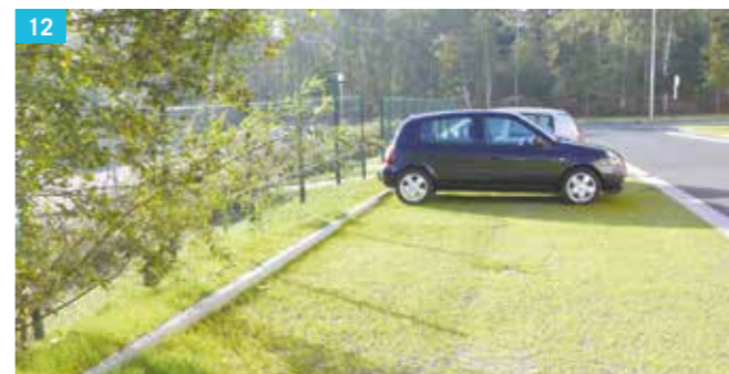
Parking avec récupération des eaux pluviales
