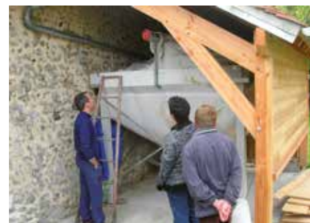
⬇ Silo Textile sous appentis, Crédit photo : Eure Solaire
