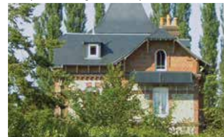
⬇ Les panneaux se déguisent en marquise.
