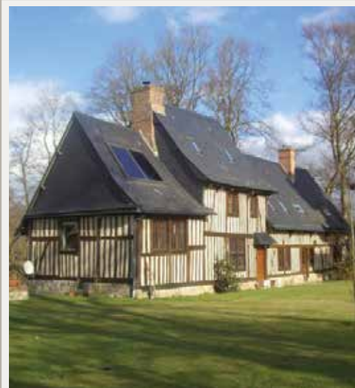
⬇ Chauffe-eau solaire individuel, De Bois Hebert
