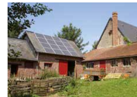
⬆ Photovoltaïque, Cauchy installateur
