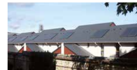
↓ Chauffe-eau solaire individuel, Gilles Thorel, Architecte
