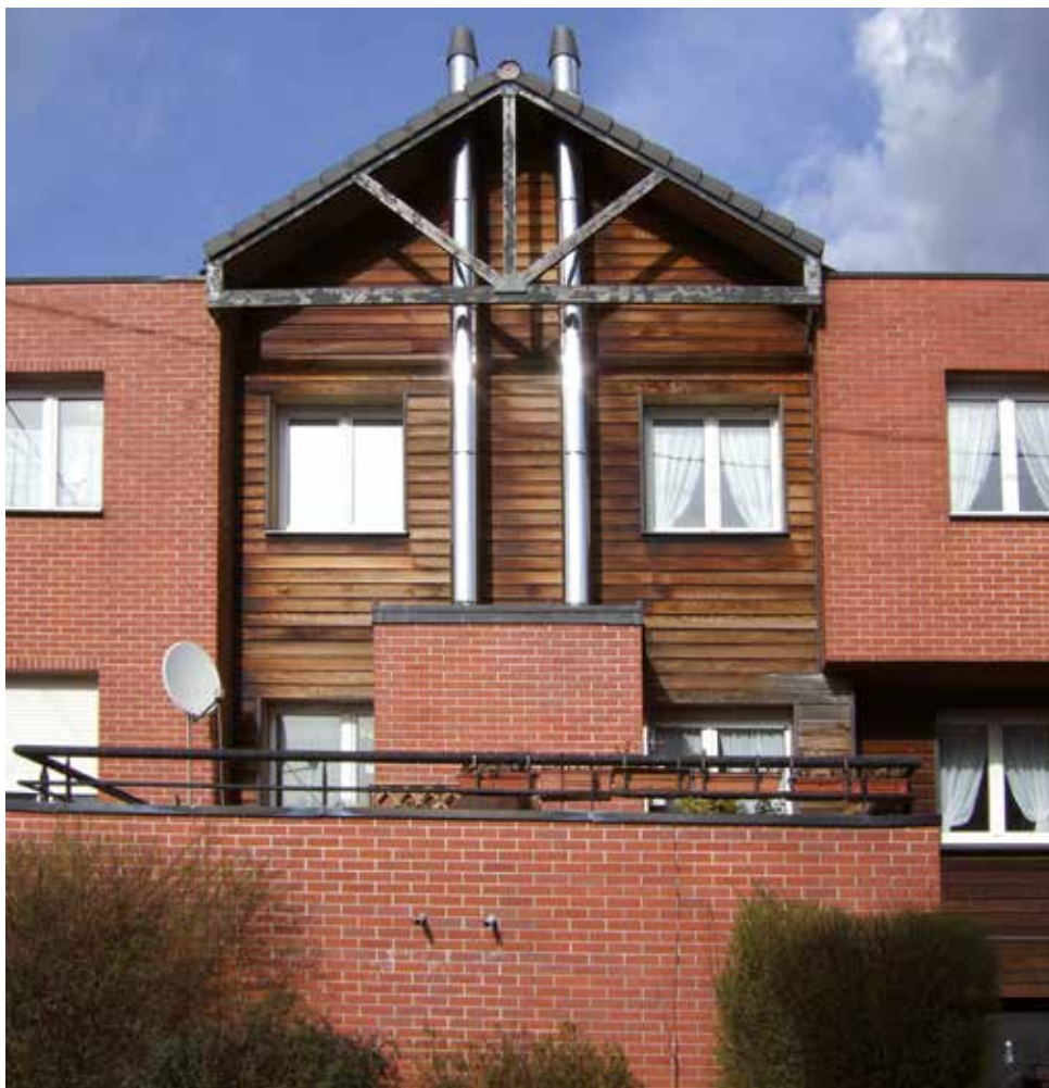
⬆ La construction annexe dissimule le dispositif de chauffage (chaudière et silo de stockage), concept EnergyBox Okofen
