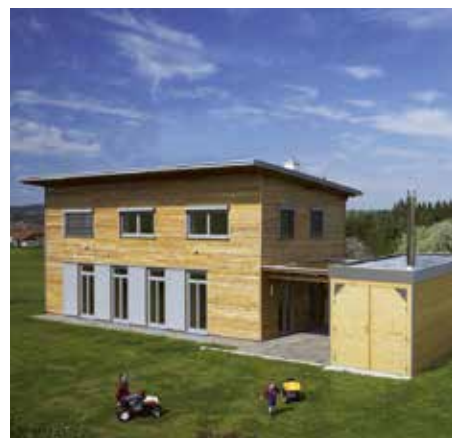
⬆ La construction annexe dissimule le dispositif de chauffage (chaudière et silo de stockage), concept EnergyBox Okofen
