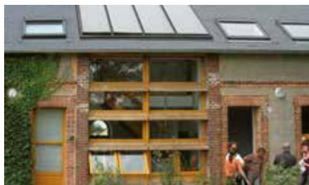
⬇ Système solaire combiné, Photo : Eure Solaire
