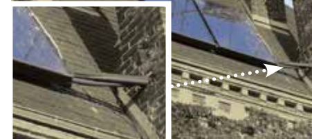
⬆ Des mauvais exemples d'intégration des éléments techniques (panneau en surimposition et visibilité des tuyaux)
