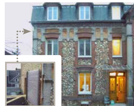
⬆ Chauffe-eau solaire individuel, capteur tube, Cauchy installateur
