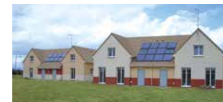
↑ Système solaire combiné, Siloge d'Evreux, Entreprise Normandie Etanch, installateur
