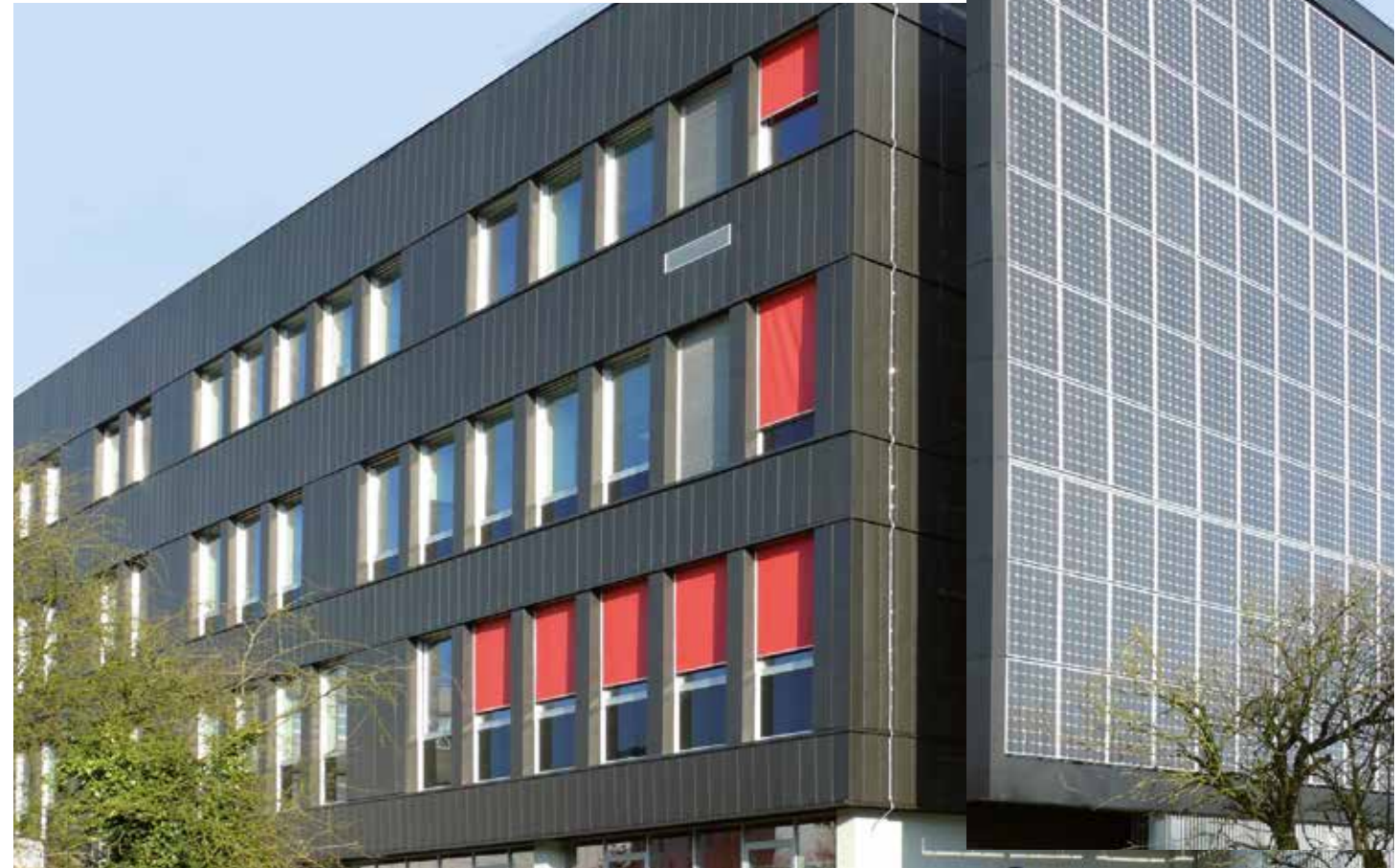
Université de Mont Saint Aignan, AZ Architecture, Architecte
