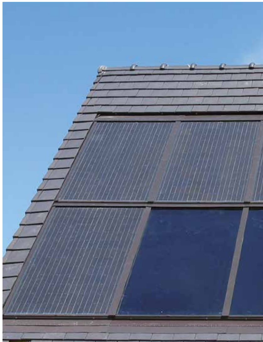
▲ Mixte photovoltaïque et Système Solaire Combiné, Solariis, installateur
