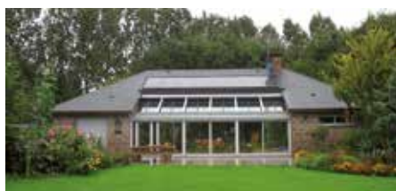
⬆ Photovoltaïque, Solariis installateur
