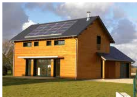
↑ Photovoltaïque, Maugy, maître d'oeuvre
