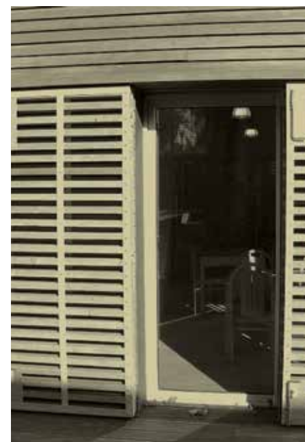
👉 Salle de réunion, Aliquante architecture : afin d'éviter les surchauffes d'été, la façade est munie de volets à claire-voie qui permettent de filtrer la lumière et donc de limiter la chaleur.
