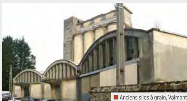
■ Anciens silos à grain, Valmont
