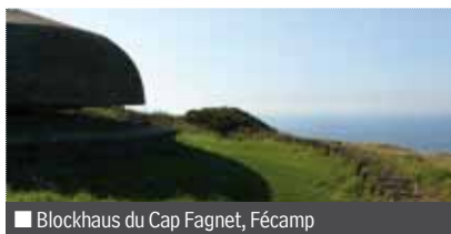
■ Blockhaus du Cap Fagnet, Fécamp
