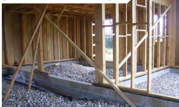
⬇ Dalle en chaux-chanvre sur hérisson de galets.
