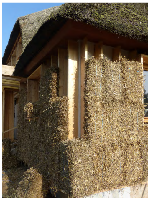
1 Les bottes de paille compressées sont insérées entre les montants bois.
