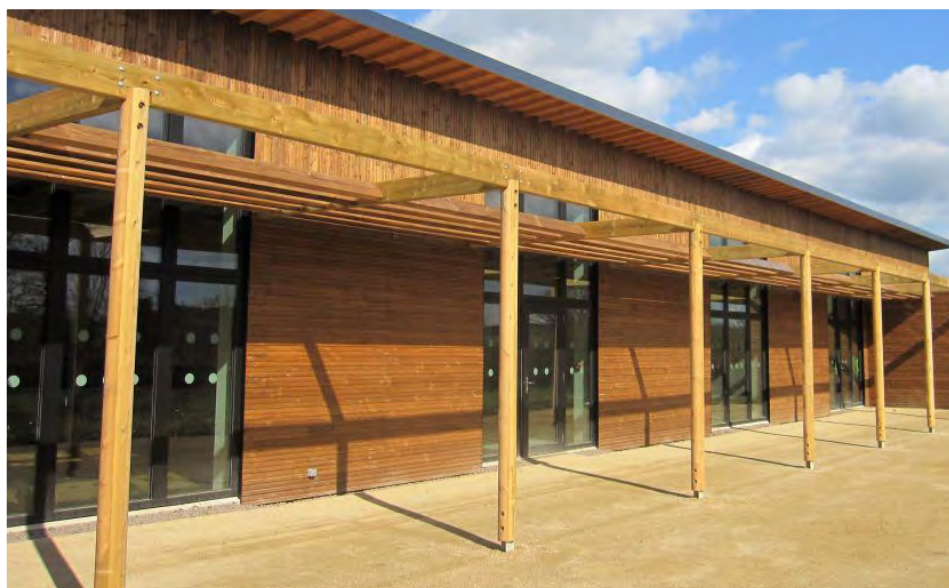
Le bois se décline sous de multiples formes à l'intérieur et à l'extérieur : structure, brise soleil, bardage, sous-face de toiture...
