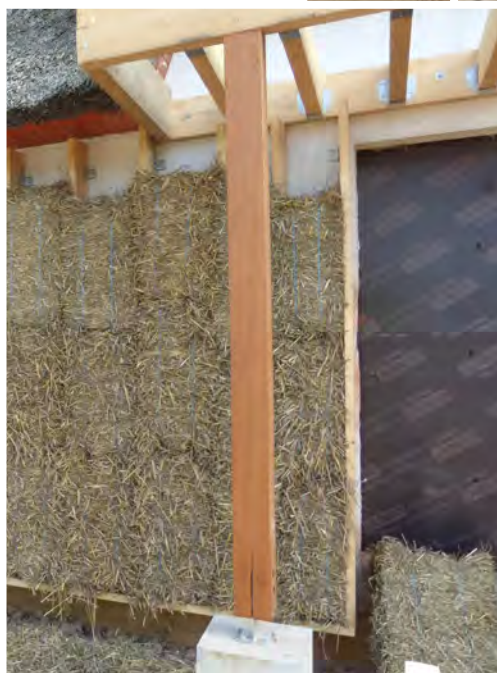
1 Les bottes de paille compressées sont insérées entre les montants bois.
