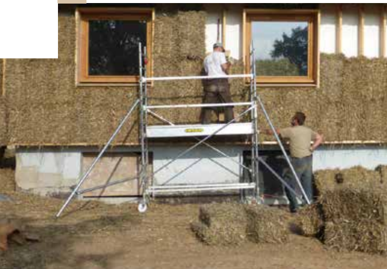
▲ Crèche communautaire à Bréauté-Beuzeville - F. Denise, Architecte
