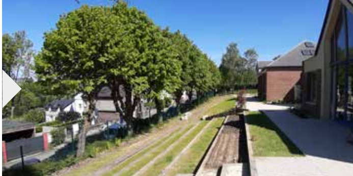
▲ Après. Des gradins ont été aménagés dans la pente pour agrandir la cour.
