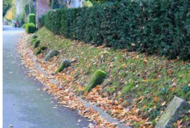
⬅ Dans les rues étroites, les véhicules et les engins agricoles sapent le pied des talus et rognent leurs flancs. Le profil des talus étant modifiés, il deviennent instables et des éboulements peuvent se produire. Pour éviter ces dégradations, des pierres chasse-roues peuvent être posées.
