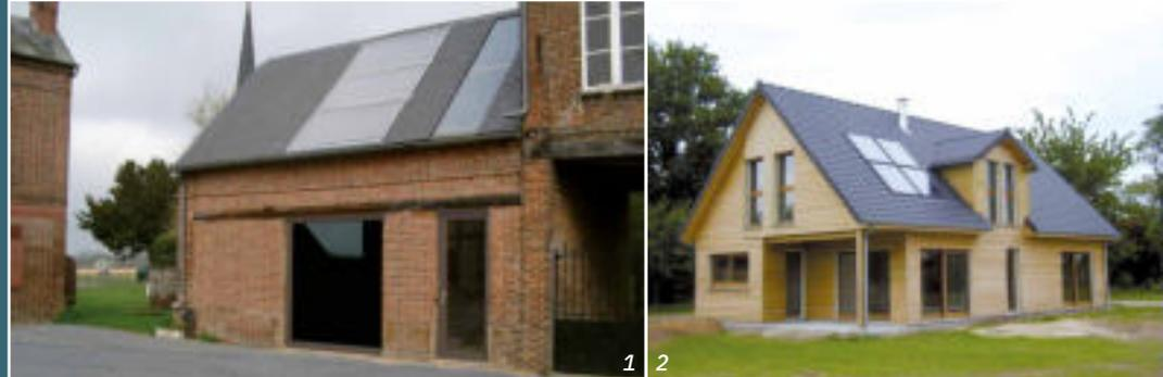
Systèmes solaires intégrés à la toiture dans la continuité d'une ouverture en façade.
