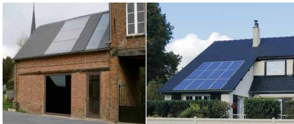
▲ Système solaire intégré à la toiture dans la continuité d'une ouverture existante en façade. Pascal Séjourné, architecte
