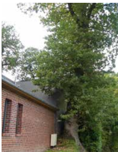
⬆ Taille de mise au gabarit : Certaines branches charpentières de ce chêne ont été supprimées pour permettre la construction d'une extension.
