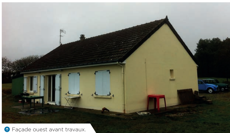
↑ Façade ouest avant travaux.
