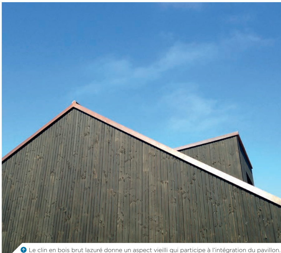
↑ Le clin en bois brut lazuré donne un aspect vieilli qui participe à l'intégration du pavillon.
